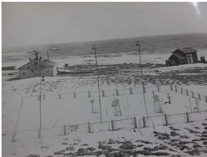
Станция АЭ Никольское постройки 1967г.
