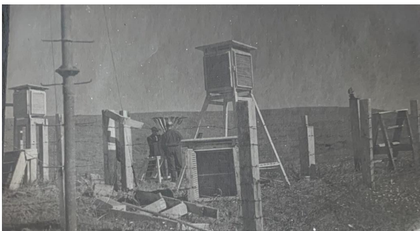
Фото 6. Ремонт метеоплощадки (установок), июль 1953 года
