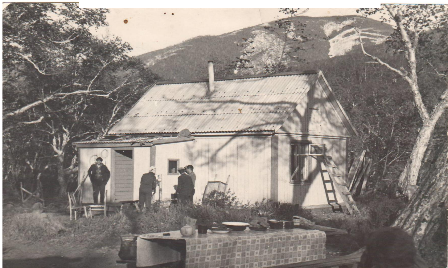
Ремонт дома наблюдателя на ГП р. Половинка – в 13,7 км от устья
