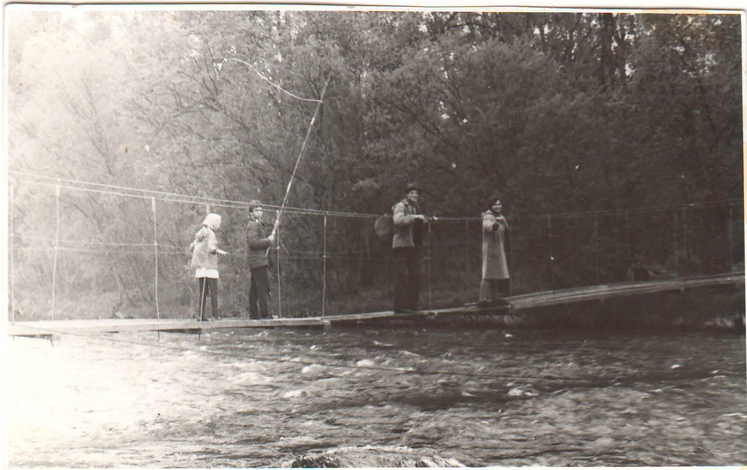
Гидрометрический мост через реку Средняя Авача
