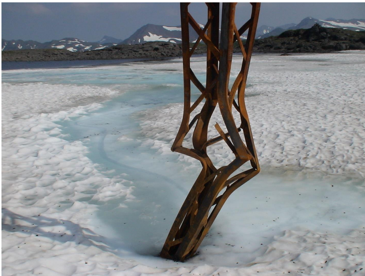
Вытаявшая опора ЛЭП, повреждённая снеговой нагрузкой на плато вулкана Горелый
