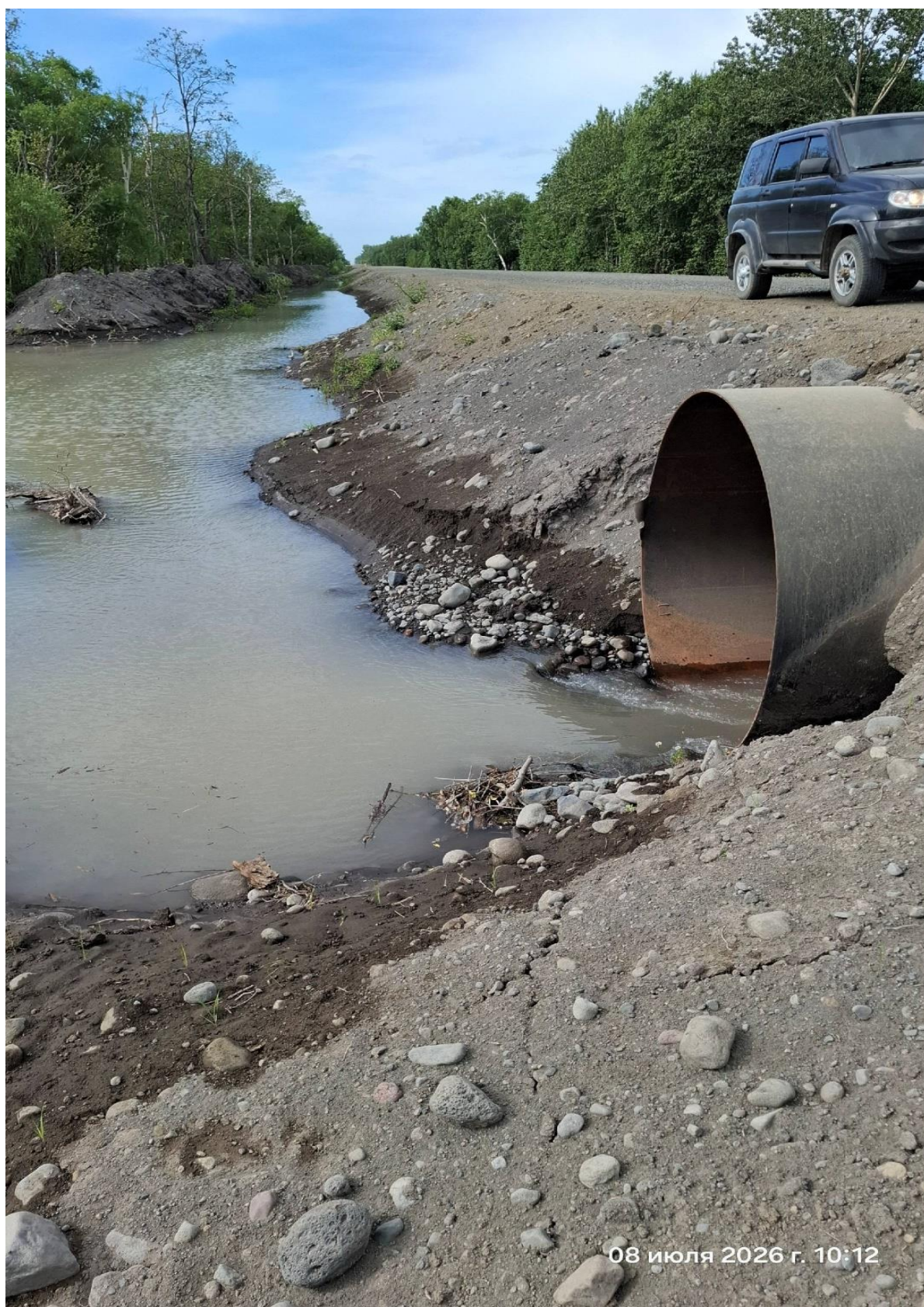
Фото 3. Воздействие водного потока «сухой реки» на откос дороги
