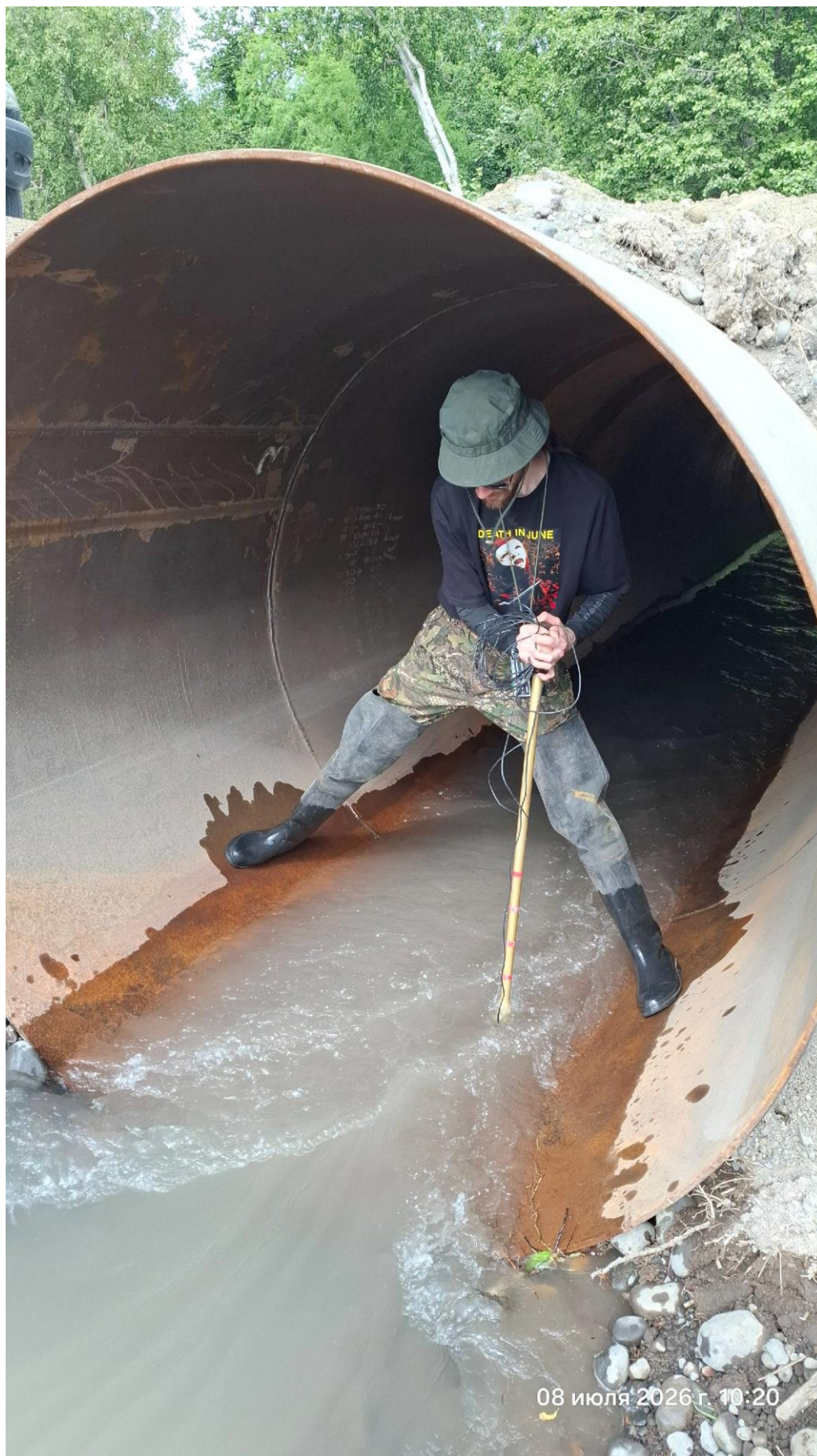
Фото 4. Измерение расхода водного потока «сухой реки» в водопропускном сооружении.
