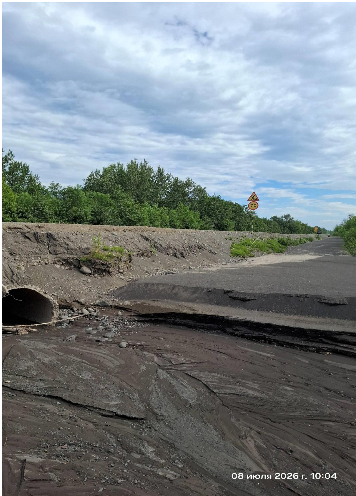
Фото 2. Последствия от воздействия водного потока «сухой реки» на откос дороги
